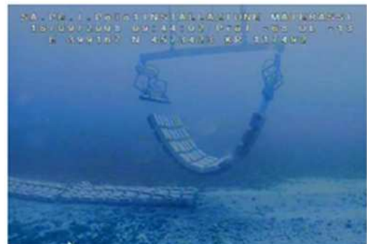
Exemple de protection externe par matelas
