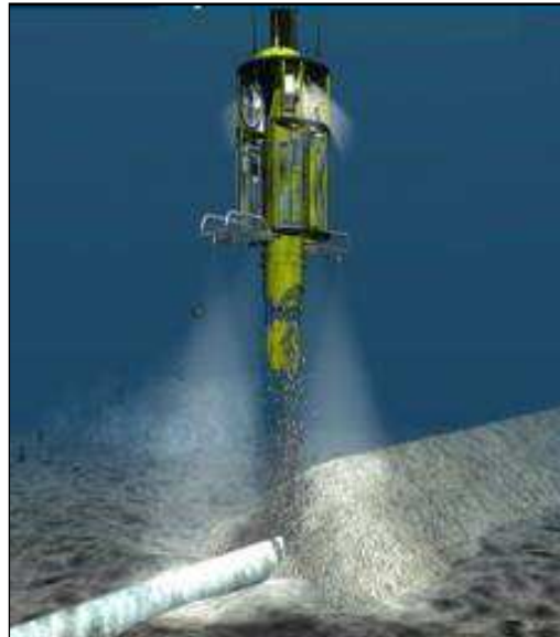
Exemple de protection externe par enrochement (Rock-Dumping)
