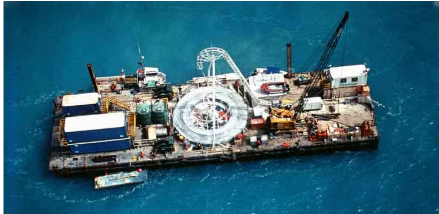
Exemple d'une barge de pose
