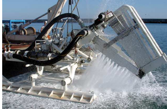
Exemple de water jetting
